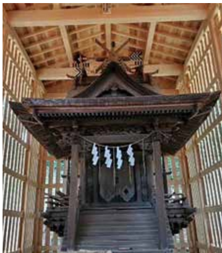
熊野神社本殿 (2022年 改修)
