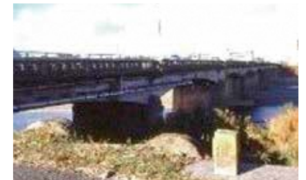
昭和46年完成の関戸橋(上流橋)
