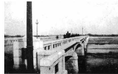
昭和12年当時の関戸橋(下流橋) (現在架け替え工事中)
