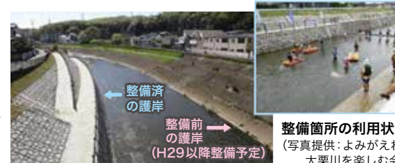
整備前・整備後の護岸の状況
