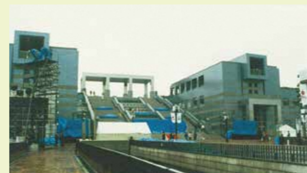
建設中のパルテノン多摩
