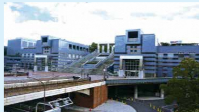
令和4年のオープンに向け大規模改修工事を行うパルテノン多摩
