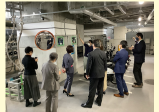
清瀬市役所地下階の免震装置
