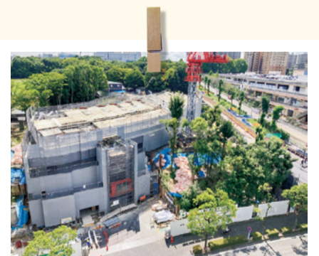
屋根部分の工事が進んでいます！
