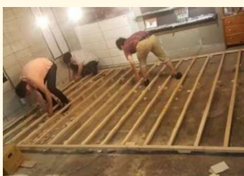
事例：未知カフェ 多摩市若者会議 DIYの様子
