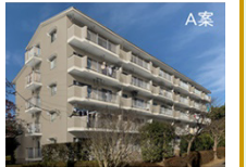
《外断熱改修等の実施》 (エステート貝取2-2)
