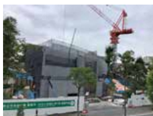
中央図書館建設中の様子
