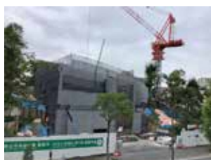
中央図書館建設中の様子
