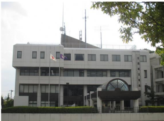
本庁舎A棟 1984（昭和59年）築 鉄筋鉄骨コンクリート造 地上4階 地下1階
