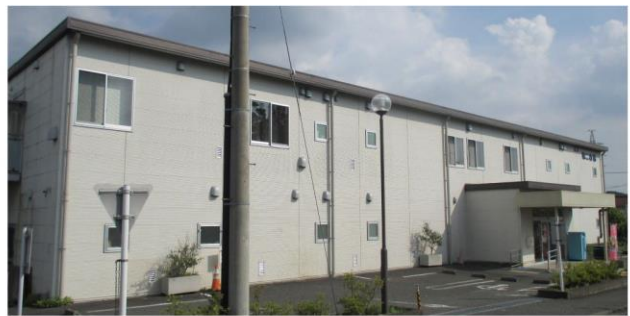
第二庁舎 2008（平成20年）築 軽量鉄骨造 地上2階
