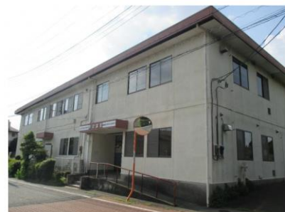
東会議室棟 1989（平成元年）築 軽量鉄骨造 地上2階
