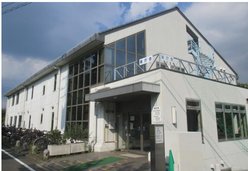
東庁舎 1994（平成6年）築 鉄骨造 一部鉄筋コンクリート造 地上2階 地下1階
