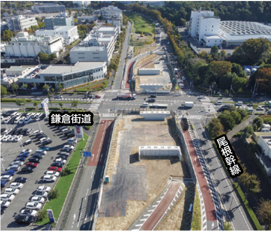
工事中の南野陸橋(仮称)
