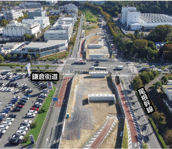
工事中の南野陸橋(仮称)
