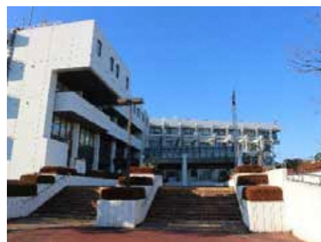
現在の多摩市役所本庁舎
