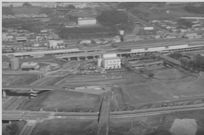
空から見た多摩センター駅周辺
