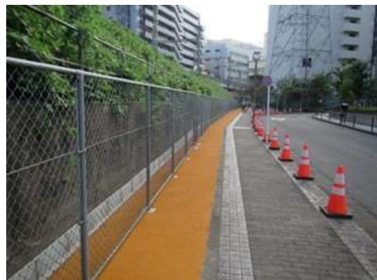
施策 26 「雨水地下浸透の推進 ～市道1-27号線～」
