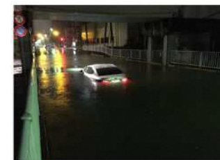
八高線アンダーパス（八王子市）
