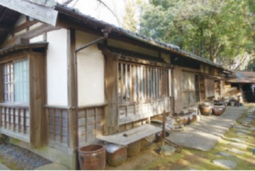
▲旧辻陶房主屋兼作業場
